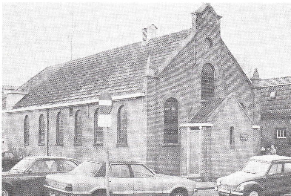
De christelijk-gereformeerde kerk aan de Kanaalstraat. Foto uit het eind van de jaren zeventig (collectie Gemeente-archief Assen)
