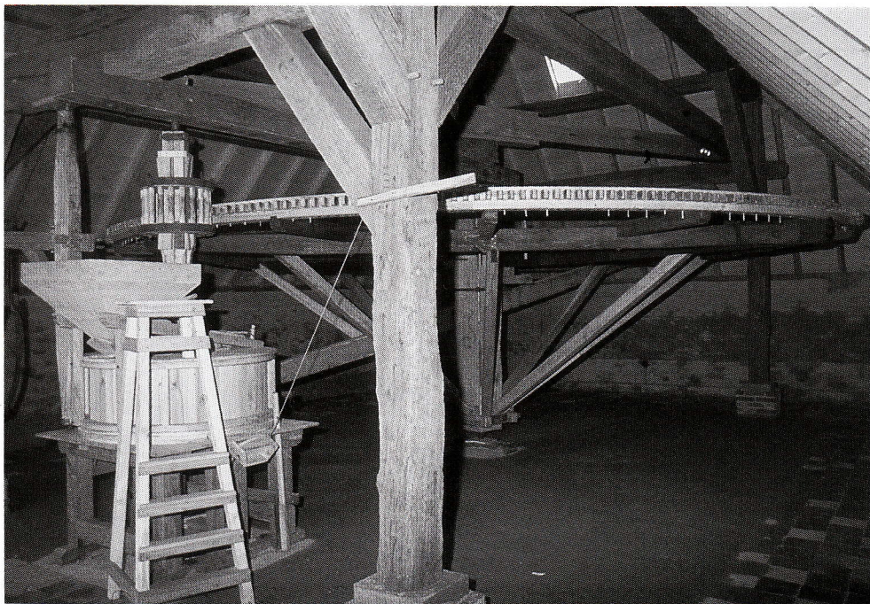
Koren-rosmolen te Zeddum in Gelderland. Deze molen werd in 1974 gereconstrueerd in een gebouw waar vroeger één geweest was. Het is het enige bekende intacte, zij het niet originele exemplaar in Nederland. Centraal op de foto het grote rad dat door een paard werd aangedreven, links het mechaniek waarin het koren werd gemalen. Zo moet de Asser rosmolen er ook ongeveer hebben uitgezien (foto Ir. A.J. IJzerman, 1974)
