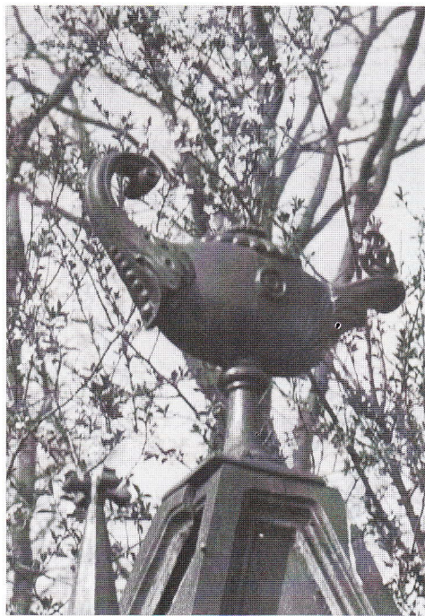
De gietijzeren doodslamp op het tentdak van het monument. Thans verdwenen (collectie Monumentenzorg van de Provincie Drenthe)
