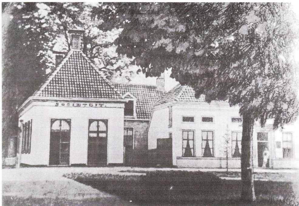
De herensociëteit aan de Brink (thans VVV/Culturele Raad). Het ernaast gelegen pand werd later vervangen door het post- en telegraafkantoor (thans Brink 41) (collectie Gemeente-archief Assen)
