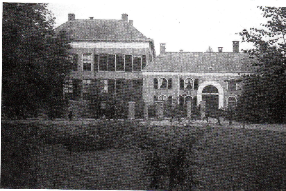
De ingang van het Huis van Bewaring, met de situatie ten tijde van de Tweede Wereldoorlog. Het hek met de stenen pilaren liep door rond het Gerechtsgebouw en is in later dagen gesloopt (collectie Gemeente-archief Assen)
