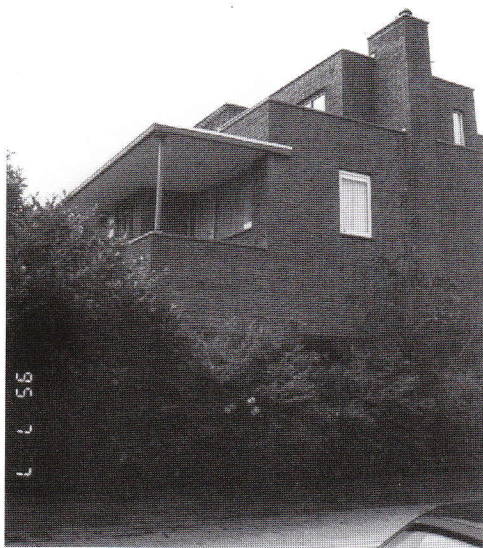
Een gezicht op het pand Vaart 41a vanuit de Emmastraat laat de blokvormige opbouw goed zien
