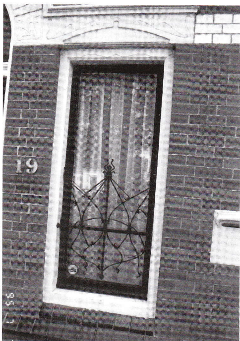
Zweepslagmotieven in smeedijzeren hekwerk en boven de vensters van het pand Vaart 19
