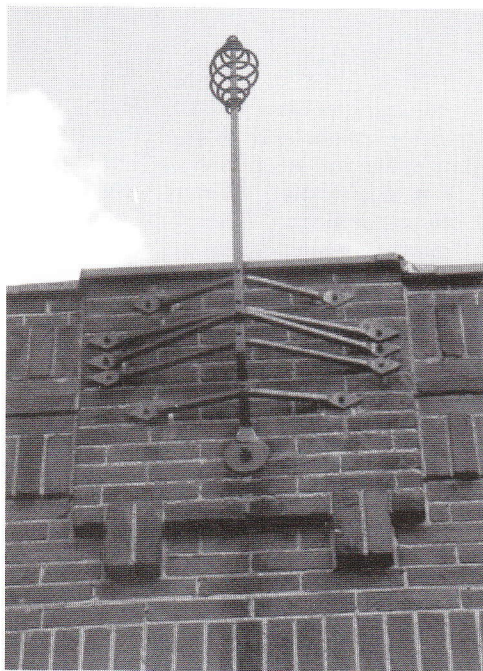
De fraai gemetselde gevelbeëindiging met het smeedijzeren sierelement van de woningen van De Vries aan de Emmastraat
