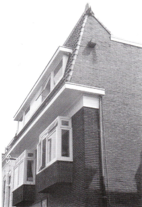
Het pand Vaart 23-23a heeft een markante vormgeving met opvallend metselwerk in de voorgevel
