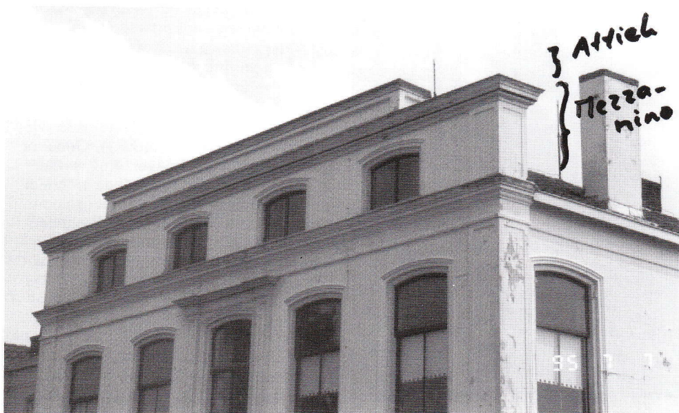
Gevelbeëindiging Vaart 25-29 met aanduiding van de karakteristieke onderdelen
